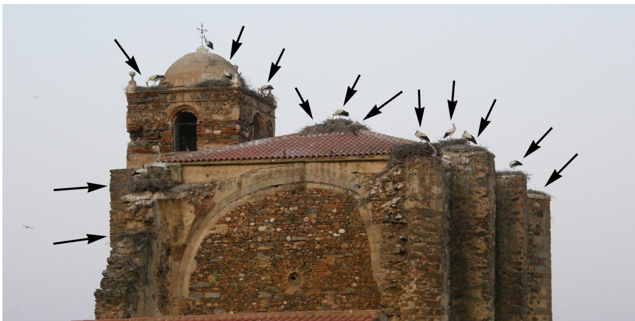
Bygning med masser af storkereder - 13 alene på denne side af bygningen. Acedera, ikke langt fra Trujillo, Extremadura, d. 7. maj 2009
